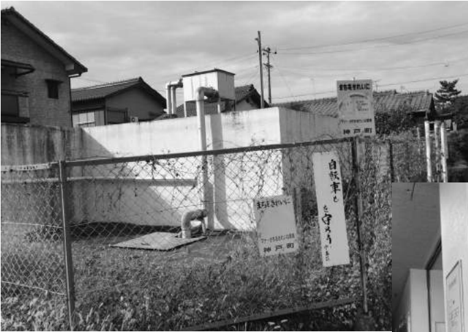
撤去される中島区集中浄化槽
