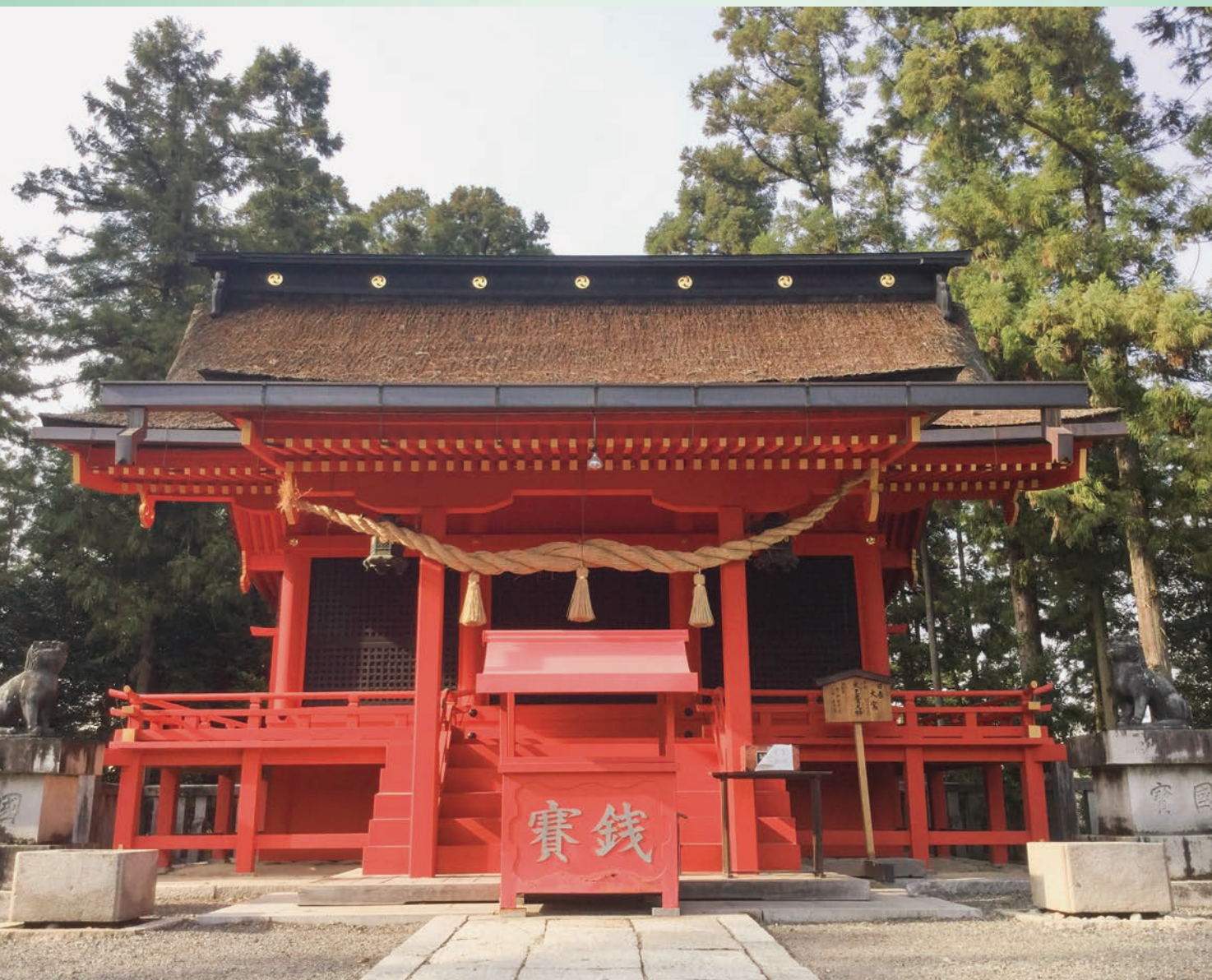
日吉神社本殿（県重要文化財）
