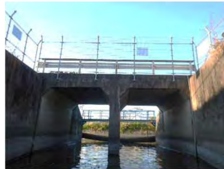
溝橋（柳瀬74号線1号橋）
