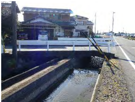
RC床版橋（横井15号線1号橋）
