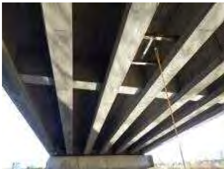
PCT桁橋（新橋）
