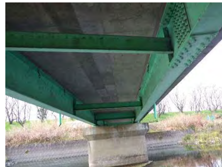
鋼H桁橋（浜崎橋）
