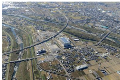
▲東海環状自動車道 大野神戸IC付近
