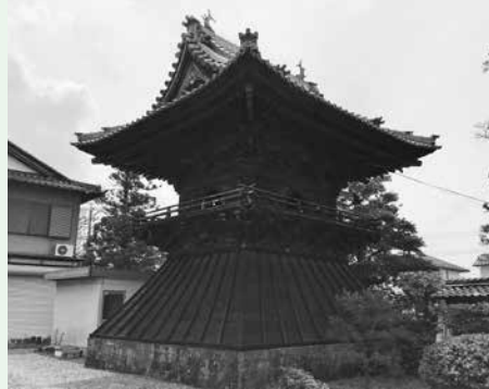
善学院の鐘楼（町重要文化財）
