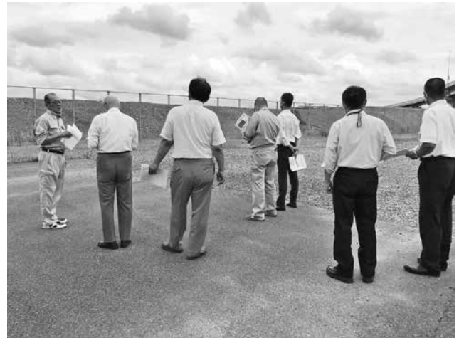
西座倉地区土地区画整理組合の 公共発生土整地工事
