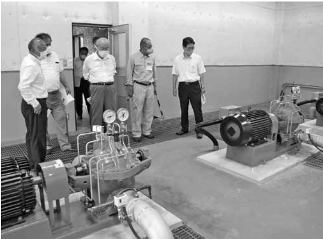
北部水源地電気機械設備改修工事
