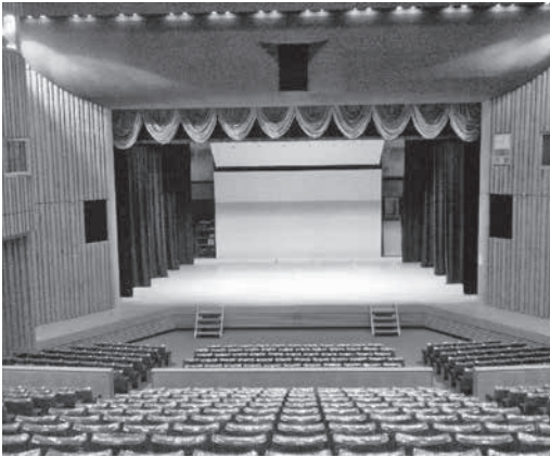
大ホール等改修予定の中央公民館
