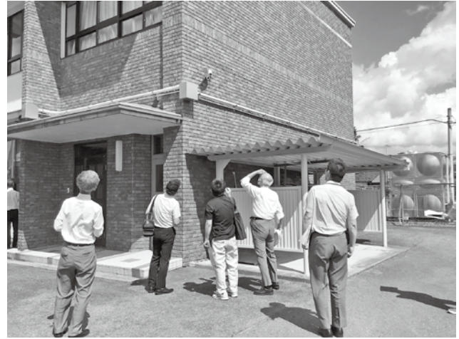
現地視察 (南平野小学校北舎外壁等修繕工事)
