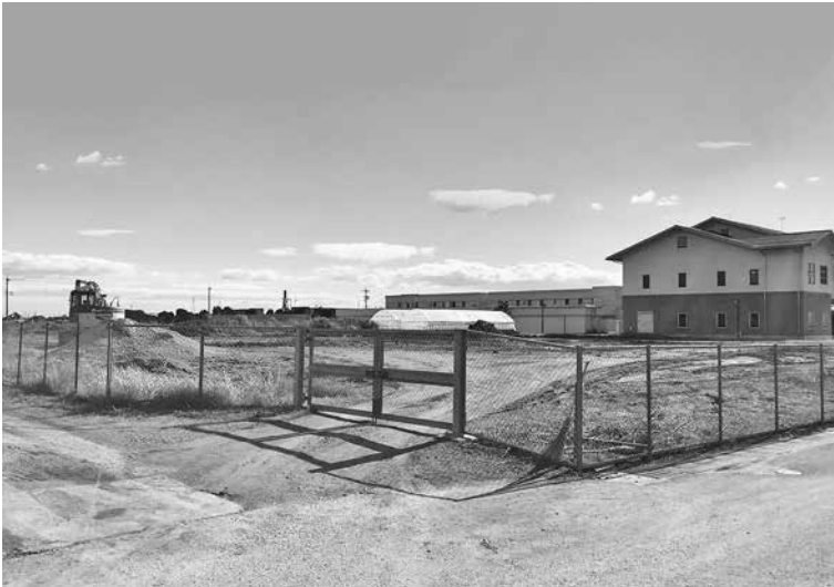
エコプラザ移転予定地（浄化センター敷地内）
