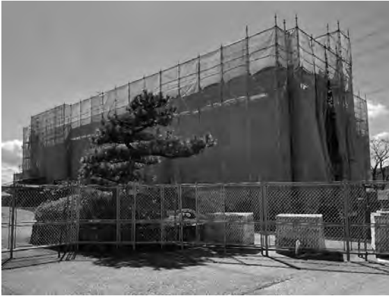
改修工事中の児童館開設予定施設のふれあいセンター
