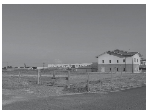
建設予定地（神戸浄化センター敷地内）
