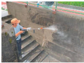
▲通路内部を高圧洗浄
