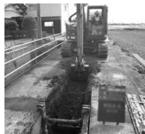
下水管布設工事 [7億9,032万7千円：公共下水道特別会計]
