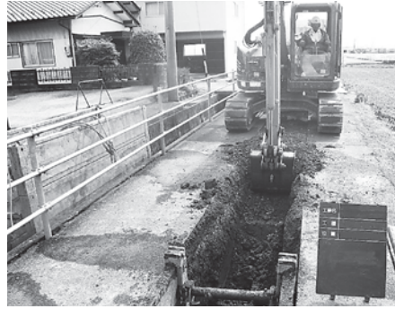
下水道布設工事 [7億6,164万3千円：公共下水道特別会計]
