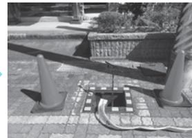
⑥地下式消火栓の金具にホースの金具を接続し、地下式消火栓専用の開閉器を使い、放水する。
