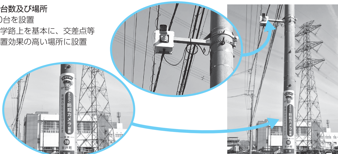
防犯カメラ設置の様子
