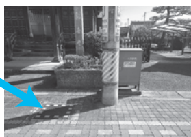
①地下式消火栓とホース格納庫
