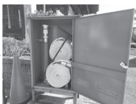
②ホース格納庫内
