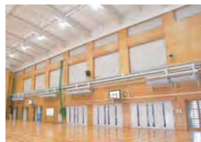
▲昨年度実施した 神戸小学校屋内運動場(体育館) 空調機器設置事業
