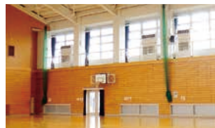
▲昨年度実施した下宮小学校屋内運動場(体育館)空調機器設置事業
