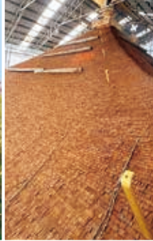
▲葺き替え工事が完了した屋根
