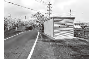
▲陸閘閉塞用資機材保管庫
