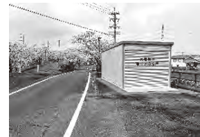
▲陸閘閉塞用資機材保管庫
