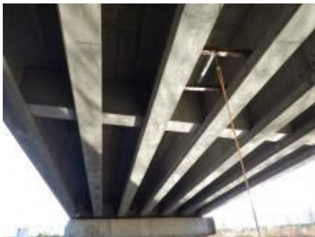
PCT 桁橋（新橋）
