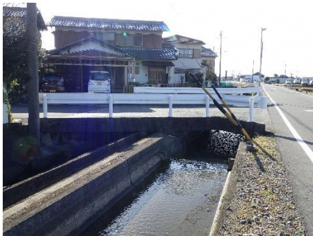
RC 床版橋（横井 15 号線 1 号橋）
