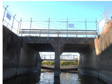
溝橋（柳瀬 74 号線 1 号橋）
