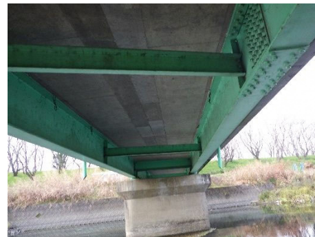
鋼 H 桁橋（浜崎橋）
